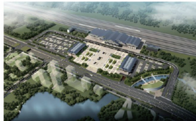
张家界综合客运枢纽建设项目
