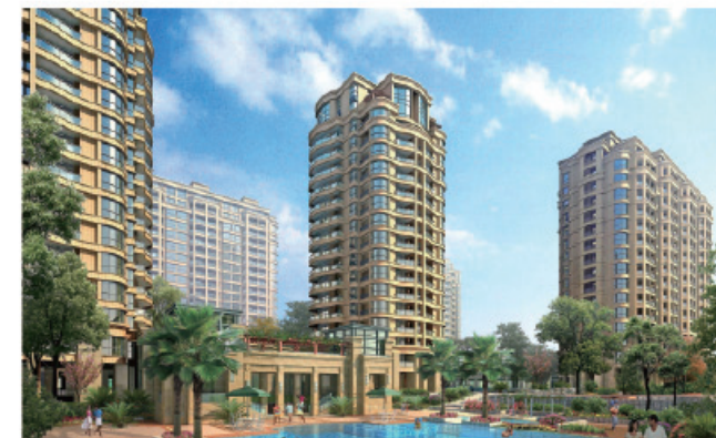
杭州海航绿城项目
