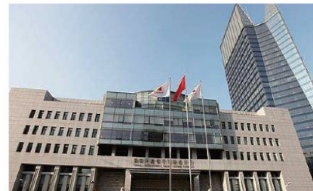
国网西咸供电公司智能化系统工程
